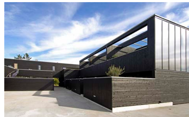
Bjørnveien 119, fasadeintegreerte solfangere
