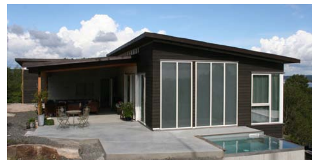
NorDan Solar på enebolig i Stavern
