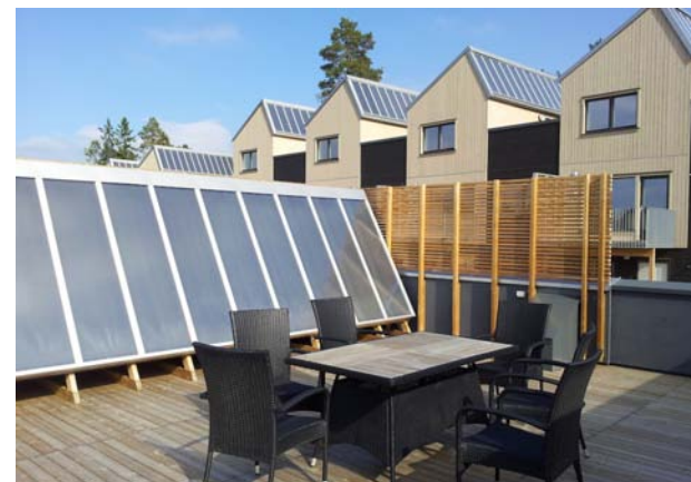
Stenbråtilla, 34 rekkehus med solvarmeanlegg
